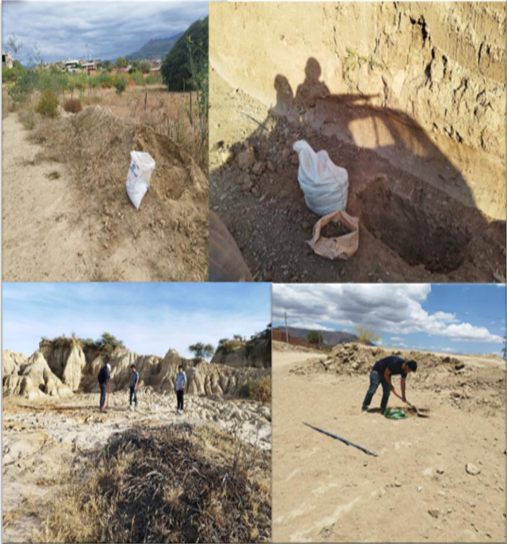
Figura 3.3 Excavación de calicatas.
