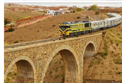
Figura N. ° 5 Puente ferroviario
