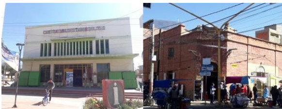
Figura Nª Cine Teatro Municipal- viviendas particular de 1922
