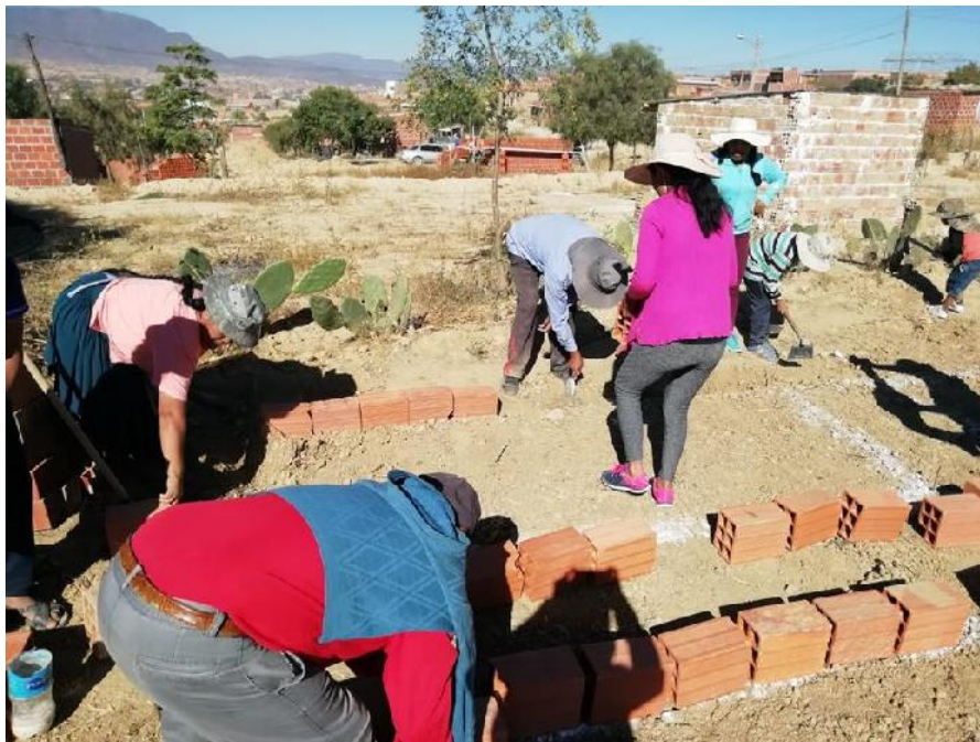
Ilustración 39: Aparejo de ladrillos en parcelas - Elaboración Propia
