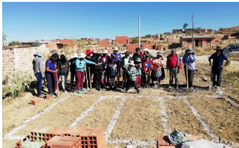
Ilustración 38: Replanteo de parcelas - Elaboración Propia
