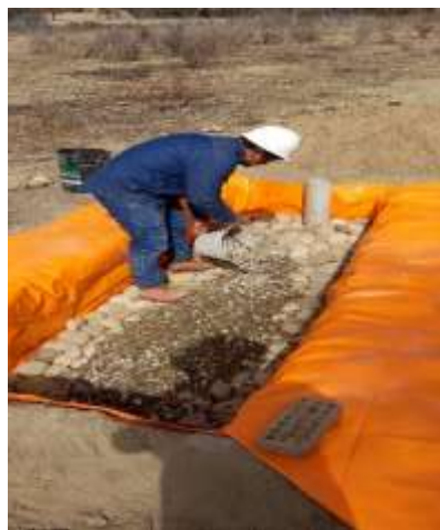
Colocado de grava y el tubo de salida en el humedal
