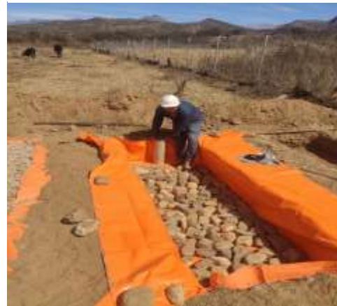
Colocado de piedras y el tubo de salida en el humedal
