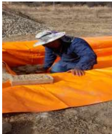
Colocado de grava y el tubo de salida en el humedal
