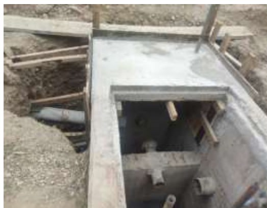
Ampliación del desarenador a la PTAR
