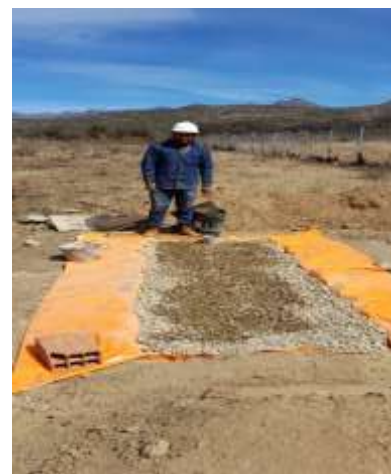
Colocado de grava y el tubo de salida en el humedal
