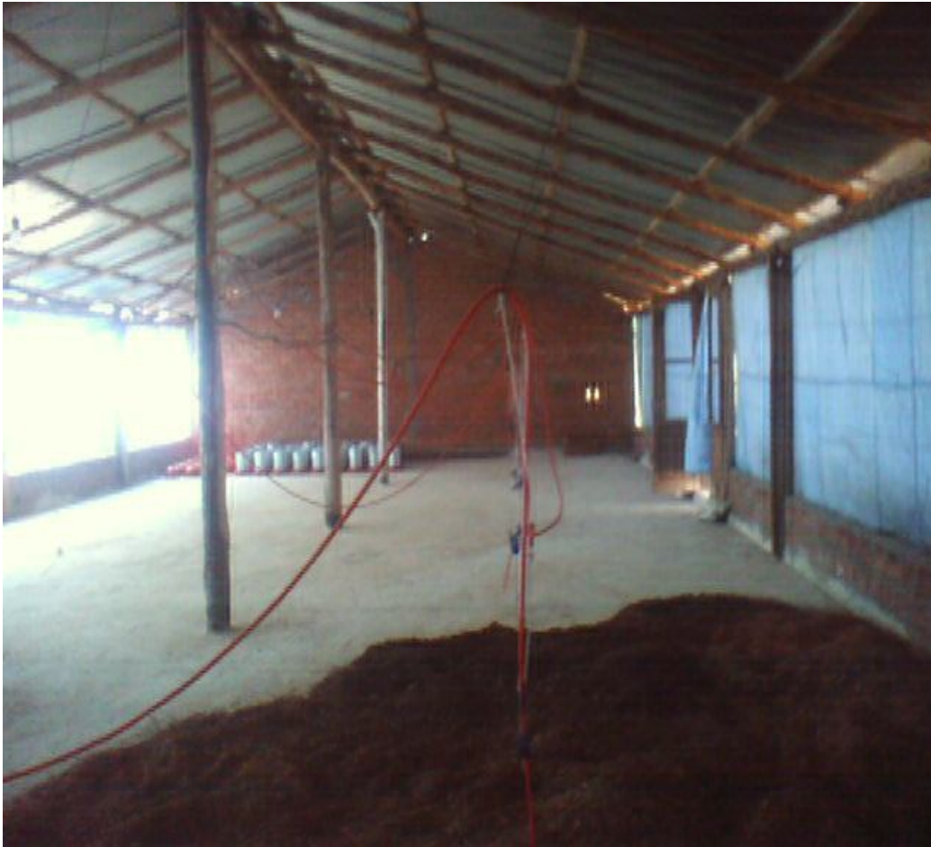
Preparación del galpón: Galpón de Santa Ana Cebollar
