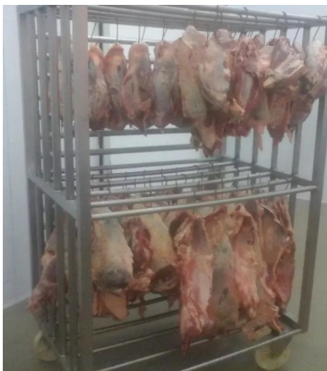
Figura 2- 16 Pallet carro cámara frigorífica para colgar carnes
