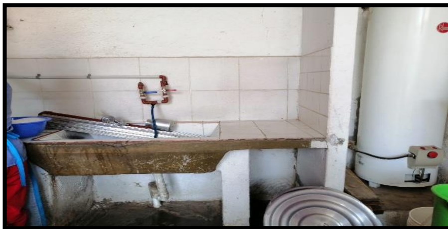
Figura 3-11 Área de lavandería
