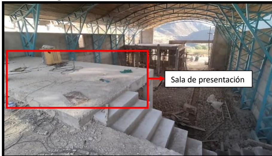
Figura 3-3 Nuevas instalaciones en construcción
