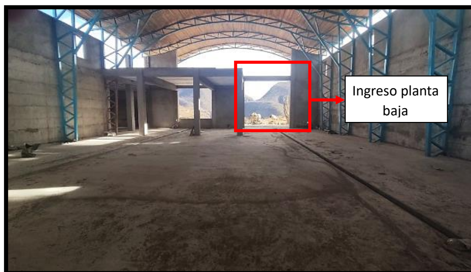
Figura 3-6 Nuevas instalaciones en construcción
