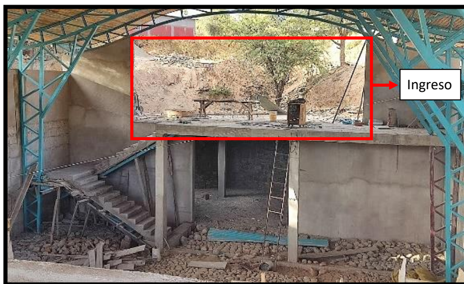
Figura 3-4 Nuevas instalaciones en construcción
