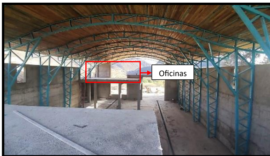
Figura 3-5 Nuevas instalaciones en construcción
