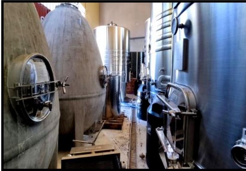
Figura 2-6 Interior del área de vinificación
