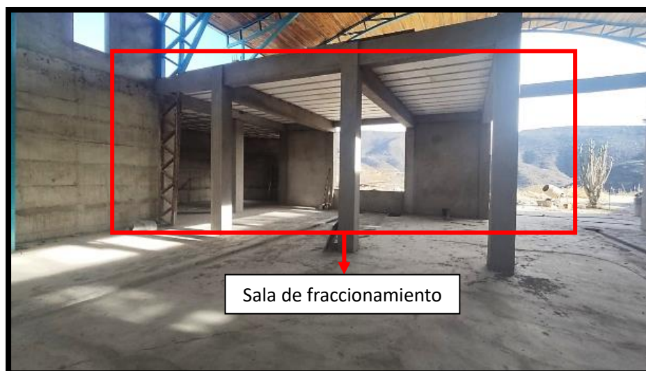
Figura 3-8 Nuevas instalaciones en construcción
