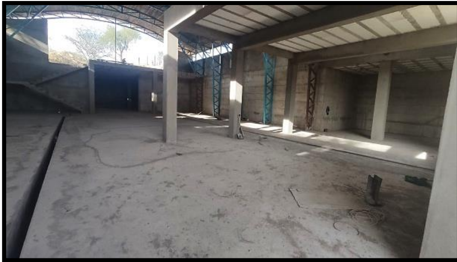
Figura 3-10 Nuevas instalaciones en construcción
