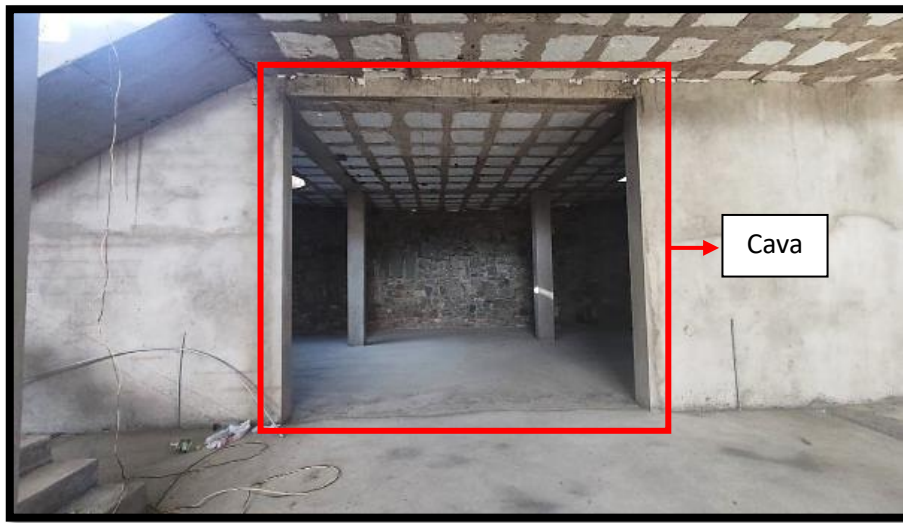
Figura 3-9 Nuevas instalaciones en construcción
