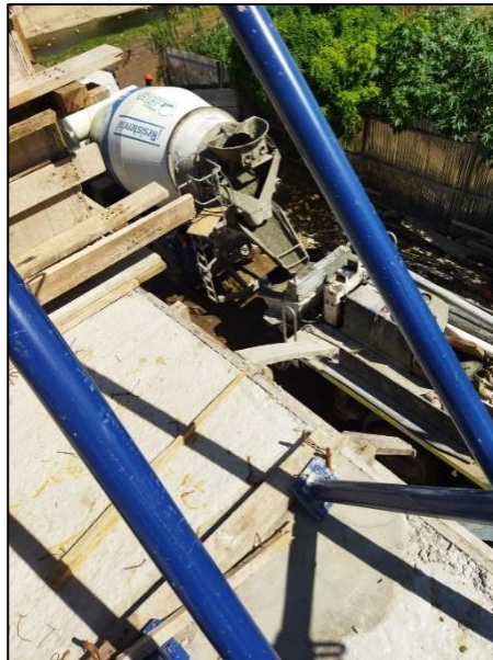
Figura 1-6 Vaciado de Hormigón en Obra.
