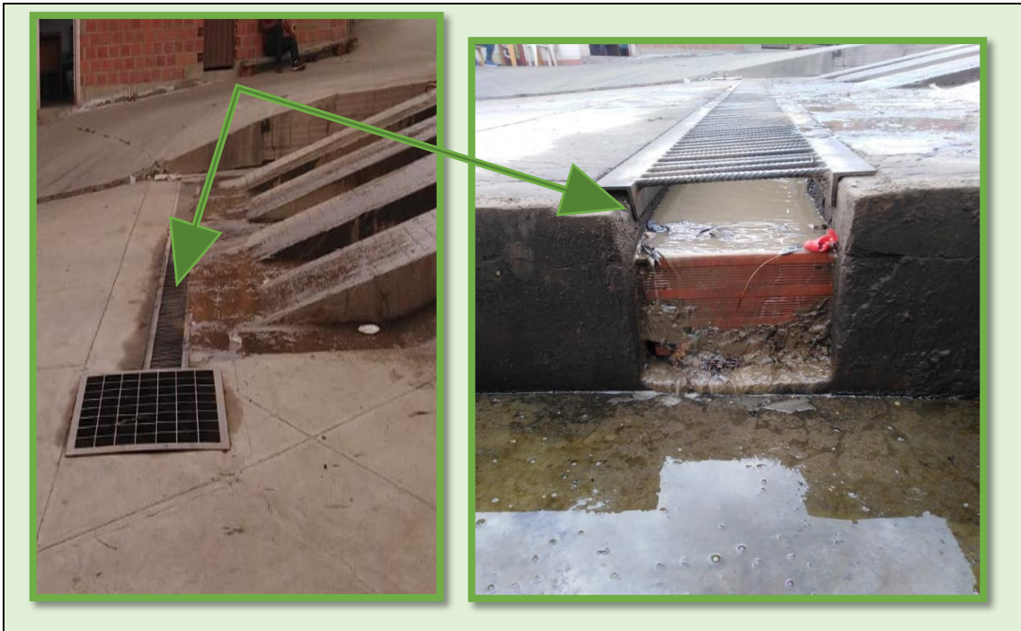
Vista a la cámara colectora
