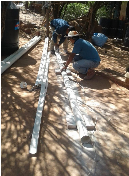
Foto 5, 6, 7, 8: Armado de la canaleta, corte de tubo, soldadura de abrazaderas metálicas.
