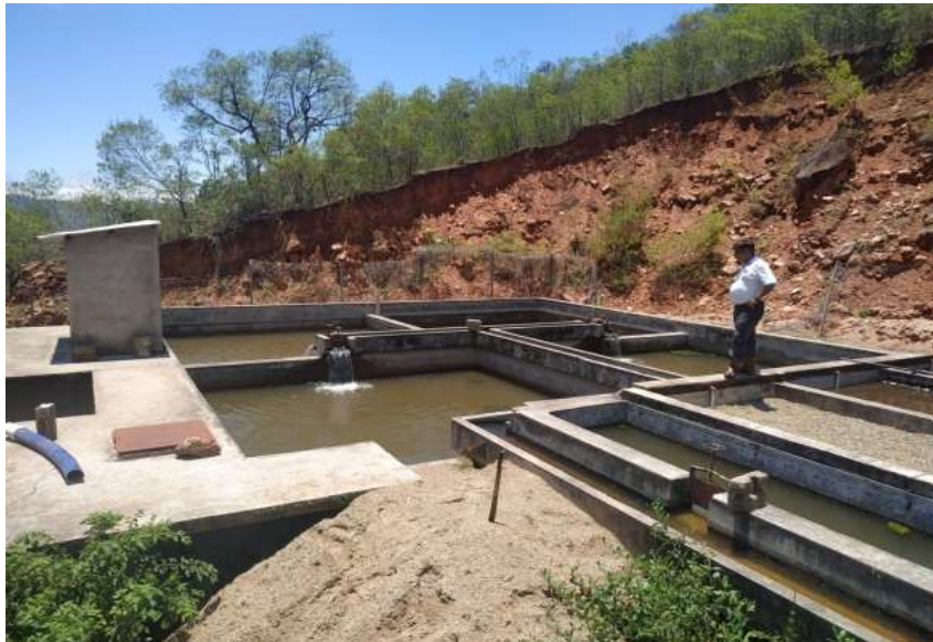
Imagen 14. Explicación del Ing. responsable en el Sistema de Filtración de agua
