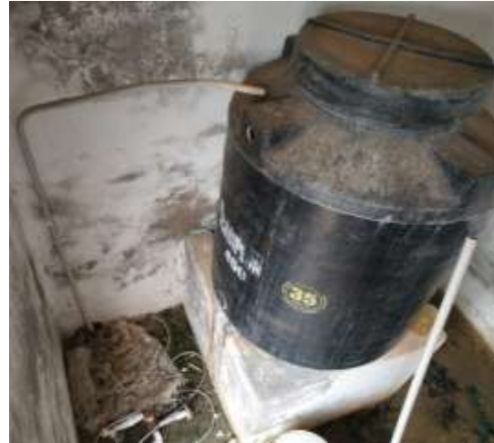
Imagen 21. Salida al Sistema de distribución del tanque de Almacenamiento 2-3.
