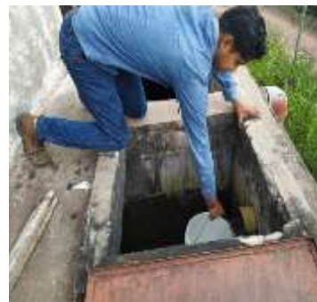
Imagen 28. Medición de Caudal del Tanque 3.
