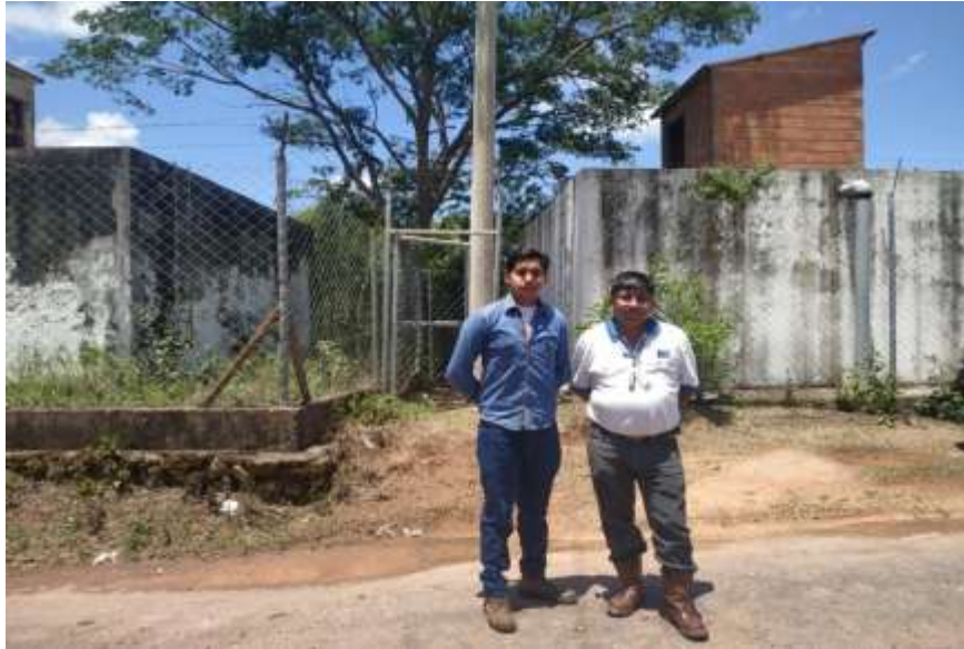
Imagen 15. Tanques de Almacenamiento de Agua
