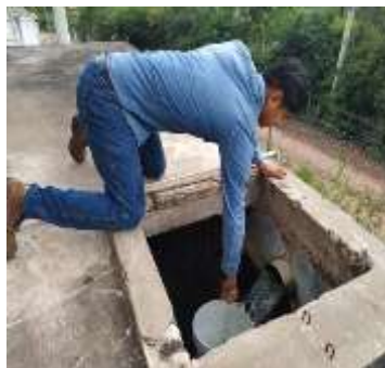
Imagen 27. Medición de Caudal del Tanque 2.
