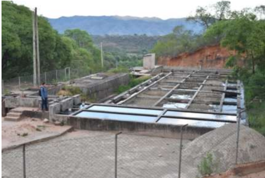
Imagen 14. Explicación del Ing. responsable en el Sistema de Filtración de agua
