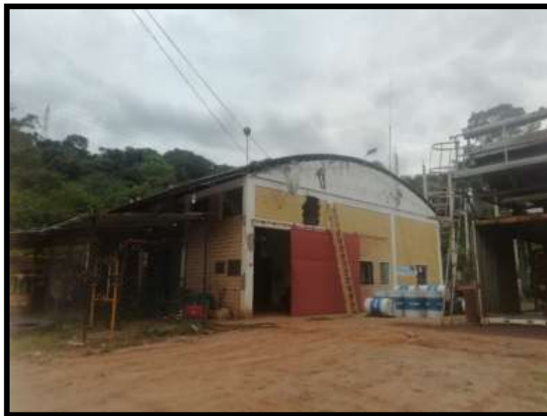
Planta de SETAR donde están ubicados oficina del personal y equipos donde dotan de energía a la población de Entre Ríos.
