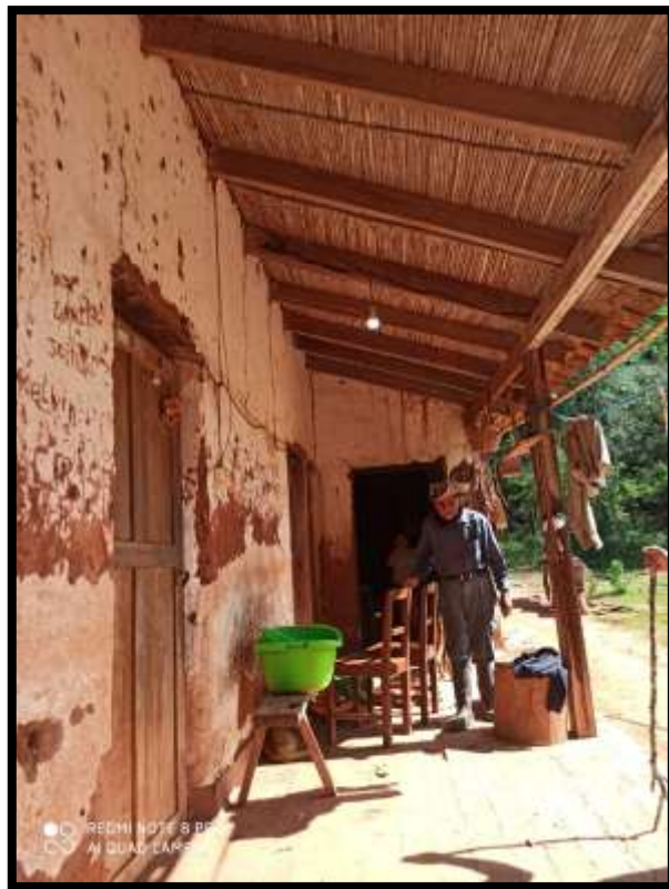
Llegamos a la casa del Sr. Pedro quien nos mostró la instalación de su panel a sus focos.
