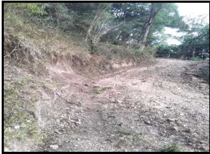
Camino precario hacia el punto dos La Moreta. Fotografía: N° 14
