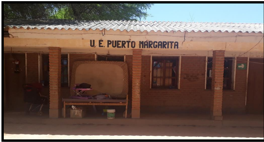
Fotografía N° 9 Colegio Puerto Margarita
