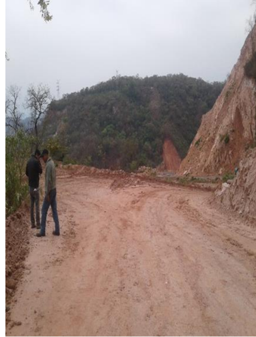
Buzón con falta de reforestación
