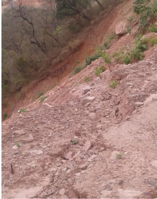
Buzón en proceso de Erosión
