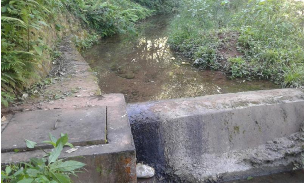
Figura N° 5 Toma de agua N° 2 "SUBIA"
