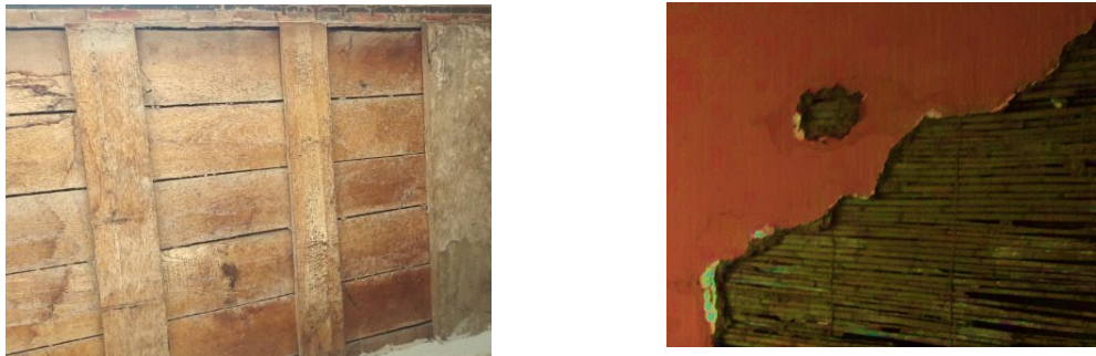
Figura 33. Envigado de madera y entramado de caña
