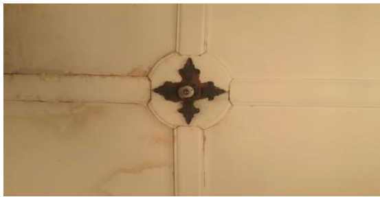
Figura 37. Cielo falso y bastidores de madera.
