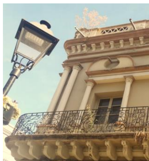
Figuras 39. Columnas dobles, cornisa, ménsula y frontones curvilíneos.
