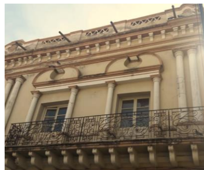
Figuras 39. Columnas dobles, cornisa, ménsula y frontones curvilíneos.
