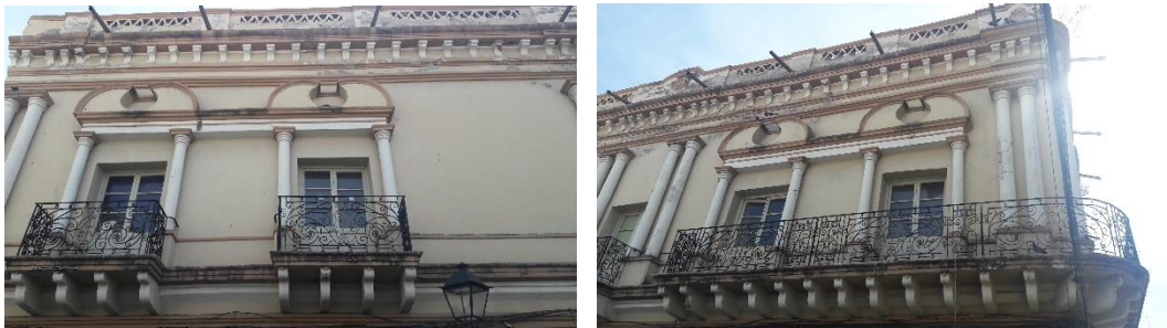
Figura 40. Balcones aislados y balcón corrido.
