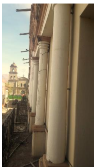
Figuras 39. Columnas dobles, cornisa, ménsula y frontones curvilíneos.
