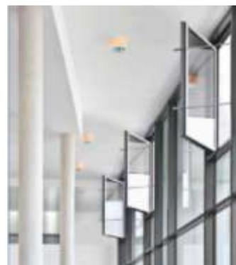
Ilustración 4.30. Apertura mecánica de ventanas.
