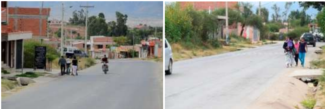
Fig. 32. Imágenes que demuestran como el desarrollo urbano entorno a la vía añadio funciones y usos que no estaban en la planificación de su infraestructura, lo que obliga al peaton a caminar por la calzada con un alto riesgo de inseguridad.
