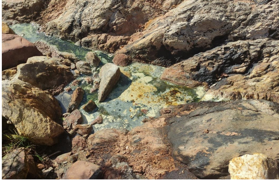
Fotografía 4. Acumulaciones de agua y rocas con hidrocarburos
