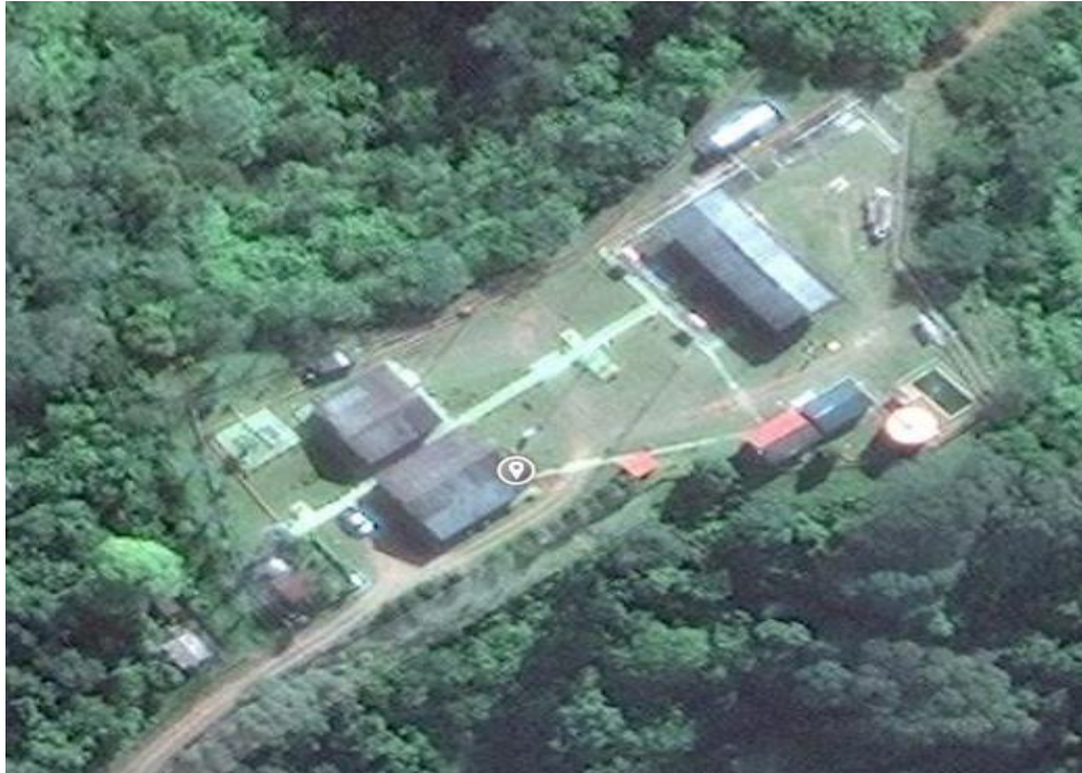
FOTO DE LA ESTACIÓN DE BOMBEO DE LA EMPRESA Y.P.F.B. TRANSPORTE S.A.
