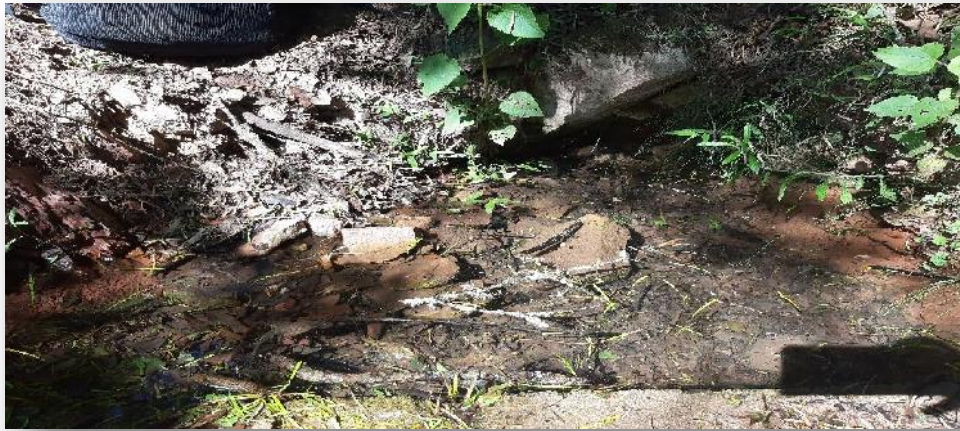
Imagen 8. Estado de las obras de captación P2, P4, P6
