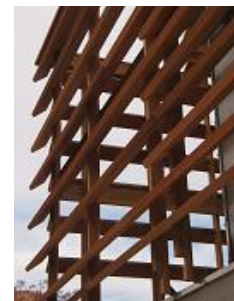
Ilustración 21: fachada con tablonces de madera
