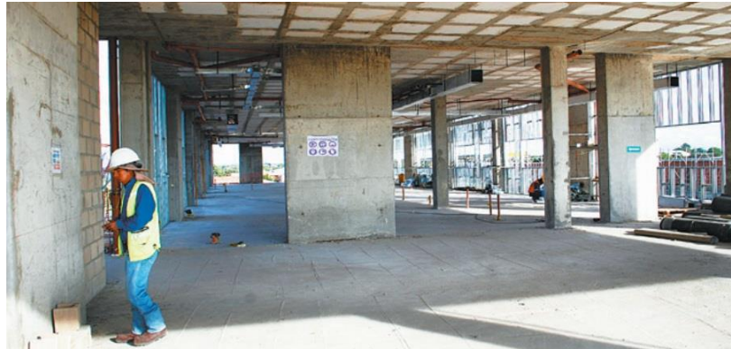
Ilustración 27: losa casetona
