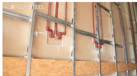
Ilustración 28: instalación de agua
