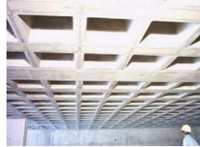
Fig. 37. Losa reticular.
