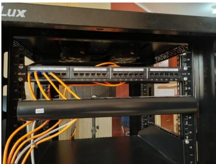
Figura 4. Conexión desde el patch panel al switch
