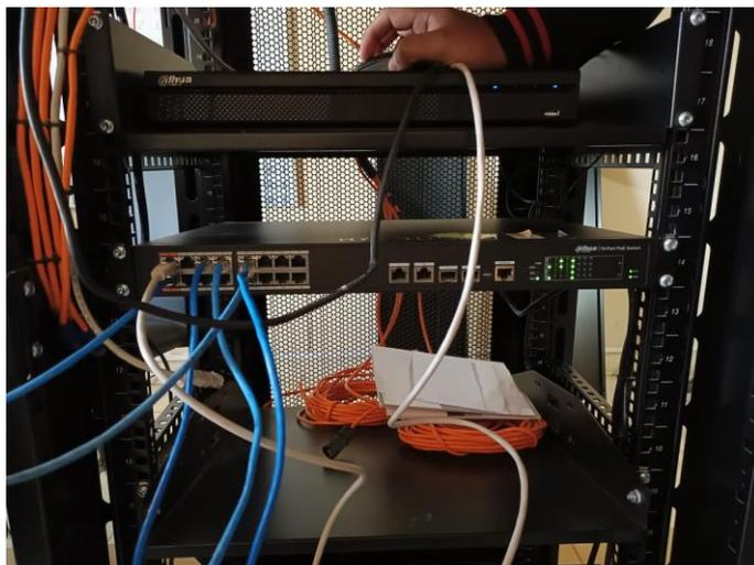
Figura 3. conexión del switch al patch panel
