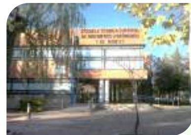
Figura 36. Escuela de Ingeniería Agronómica
