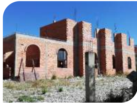
Figura 71. Nueva Construcción de la Iglesia
