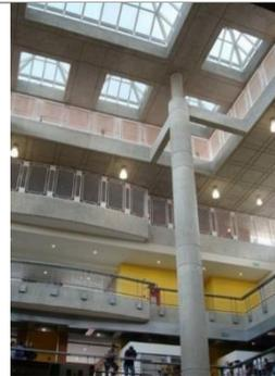
Sistema estructural aporticado con losas nervadas en dos direcciones
