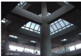
4 columnas centrales (altura 20m) que soportan la cúpula central
