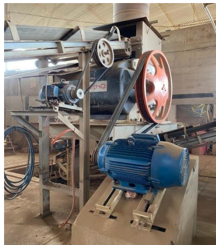
FIGURA D-10 MAQUINARIA DE EQUIPO PESADO
