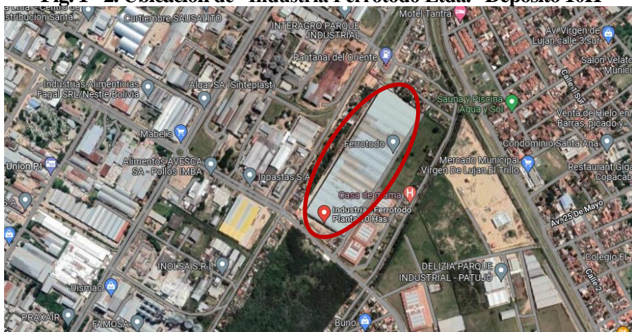
Fig. 1 - 2. Ubicación de “Industria Ferrotodo Ltda.” Depósito 10H
