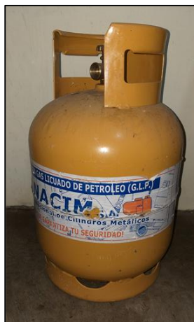
Figura 4-4 Garrafa utilizada en el sistema de calefacción actual
