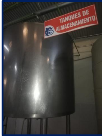
Fig.III-7. Tanques de almacenamiento
