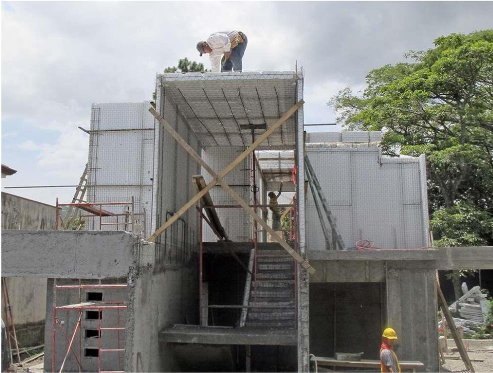
El sistema constructivo con paneles estructurales Panel 3D® se entrega listo para ser utilizado en obra, los paneles se unen entre sí mediante refuerzos en las juntas con mallas electro soldadas que van sujetas con alambre de amarre, posteriormente se ubican las tuberías de las instalaciones eléctricas y sanitarias.
