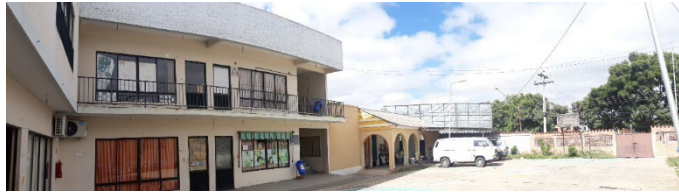
Figura 42 Área de rehabilitación
