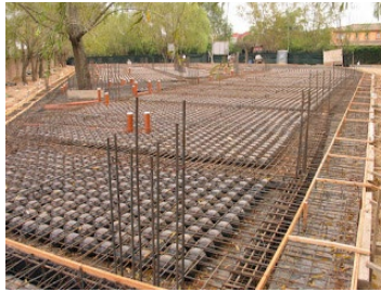
Figura 109 Losa Aligerada Prenova
