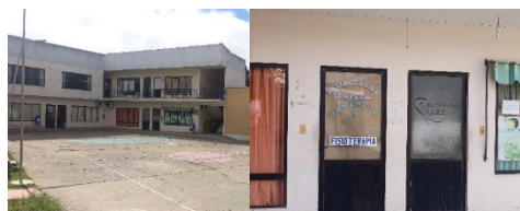
Figura 41 Área de rehabilitación
