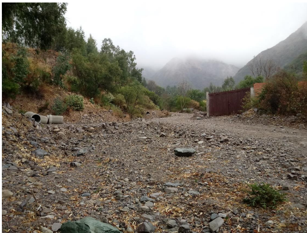
Fig. 5. Invasión de aire de quebrada y cierre de la misma.
