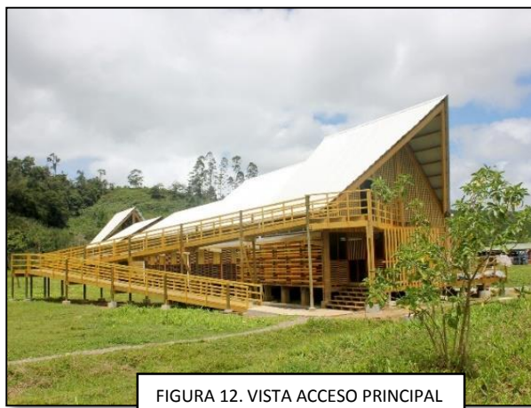
FIGURA 12. VISTA ACCESO PRINCIPAL
