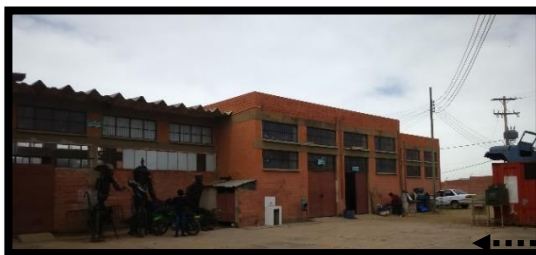
FIGURA 31. TALLERES DOBLE ALTURA
