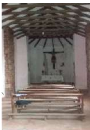
estructura de cubierta con madera trabajada
