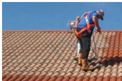
impermeabilizacion con pintura
