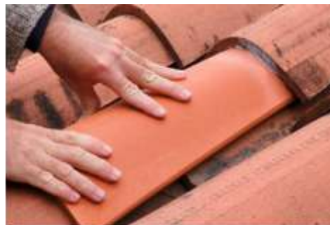
sustitucion de piezas dañadas
