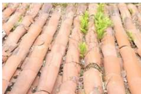
vegetacion en la cubierta
