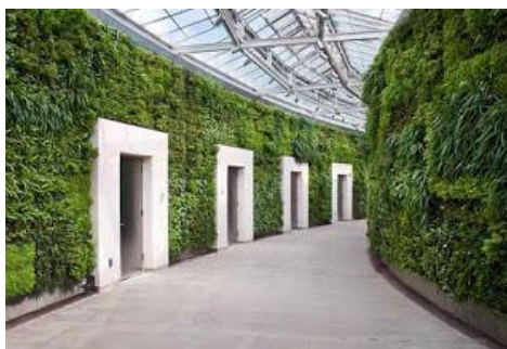
Figura 93 Fotografía de muros verdes
