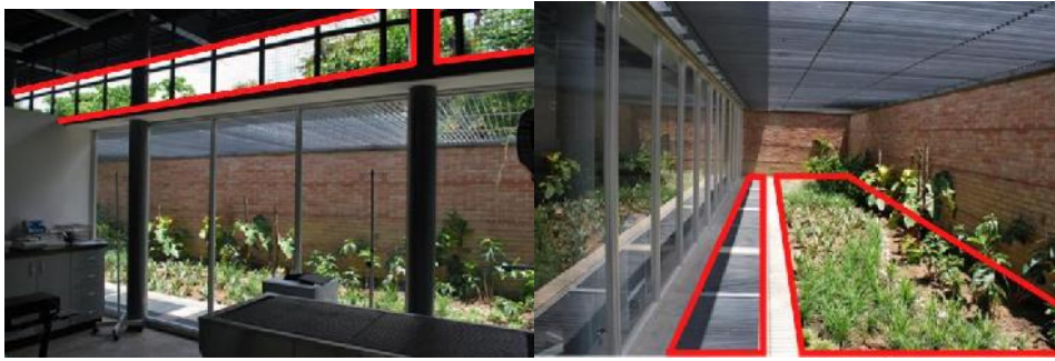
Figura 16 Ventilación y recolección de aguas de lluvia Centro de protección Animal Baruta
