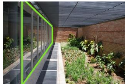
Figura 12 Ventanales de vidrio Centro de protección animal Baruta
