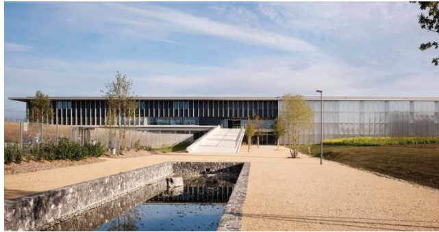
Figura 13: Vista del exterior del complejo
