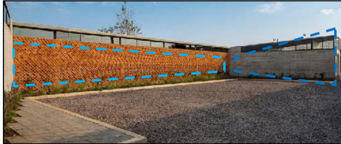
Figura 63: Uso de ladrillo visto y concreto en el proyecto
