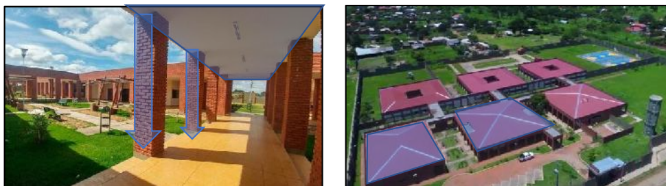
Figura 70: Materiales utilizados en la casa de acogida
