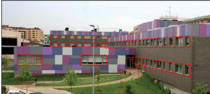
Figura 52: La casa malva cuenta con ventilación natural
