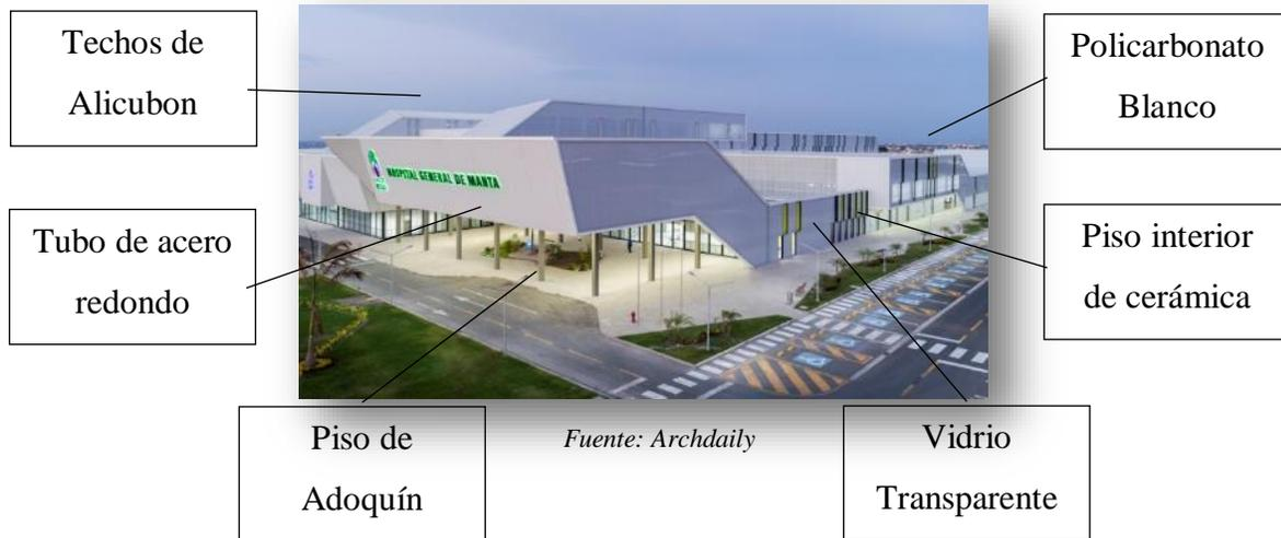
Se ha implementado un sistema articular para que la totalidad de los esfuerzos que se producen en la estructura no se transmitan a la fachada y a las carpinterías, buscando que sean absorbidos con sistemas de muelles y sistemas flexibles entre los diferentes elementos. Y la utilización del policarbonato ha dado como resultado una fachada ligera, de altas prestaciones, capaz de resistir un terremoto mediante la tecnología de las uniones.
