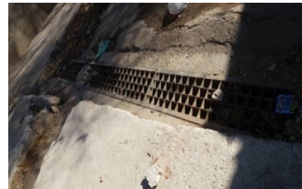
Contaminación olfativa Fuente: Elaboración propia fig. 56
