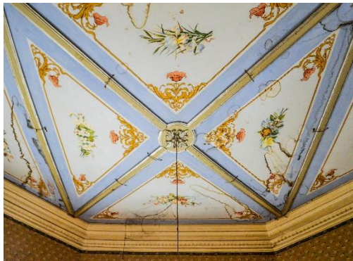
Figura 43. Cielo Falso de Tela sostenido con Bastidores de Madera.
