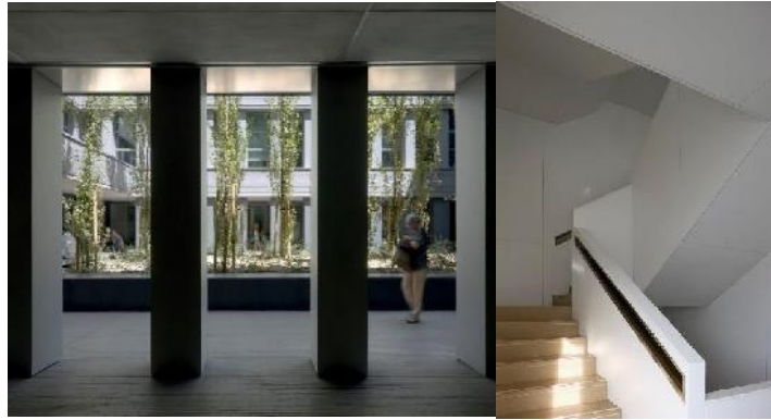
Figura 51: Elementos estructuras del edificio
