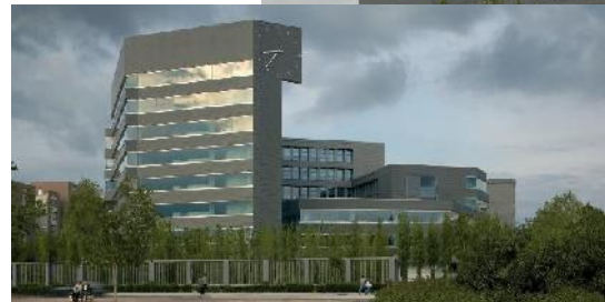
Figura 50: Fachadas del edificio
