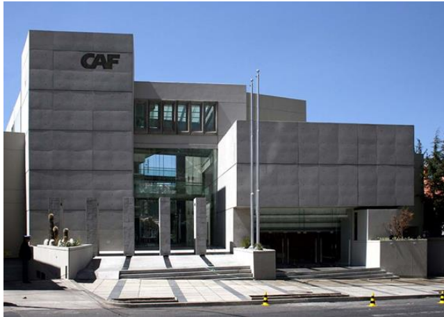
Figura 38. Edificio de la corporación Andina
