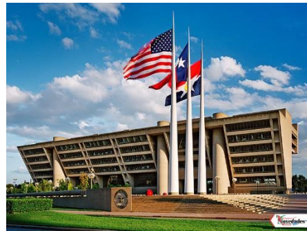
Figura 73. Edificio administrativo de Gobierno
