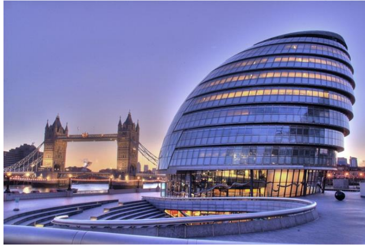
Figura 33. Edificio de Gobierno de Londres
