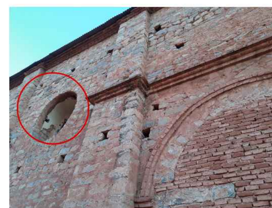
DESPRENDIMIENTO DEL REVOQUE DE YESO EN LOS BANOS DE LAS LUCERNARIAS
