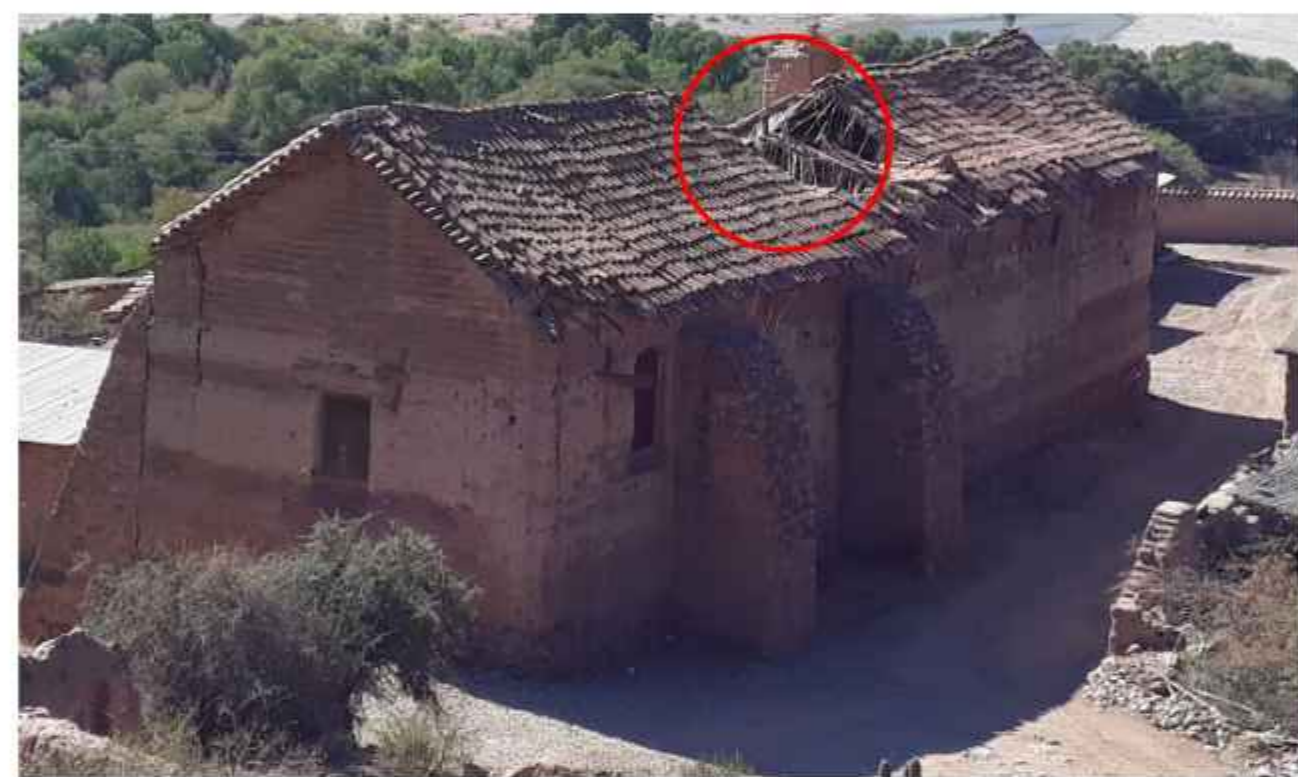
DERRUMBE DE LA CUBIERTA
