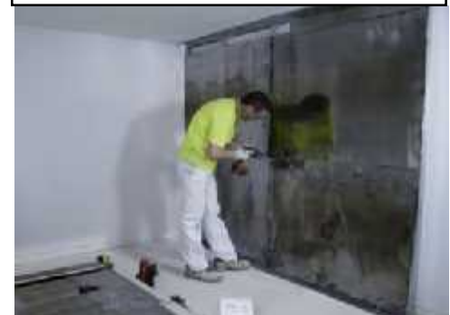
3: Fijación de láminas de plomo
