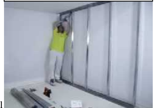
2: Instalación de la estructura metálica
