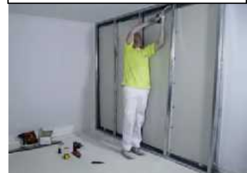
4: Instalación metálica para trasdosado
