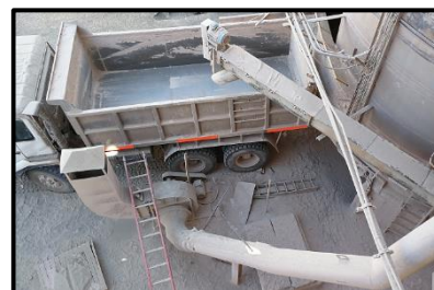
Extracción polvo de purga en volquetas
