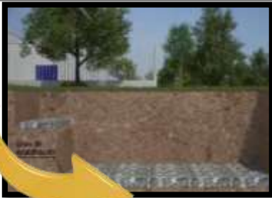
RELLENADO CON GRAVA
